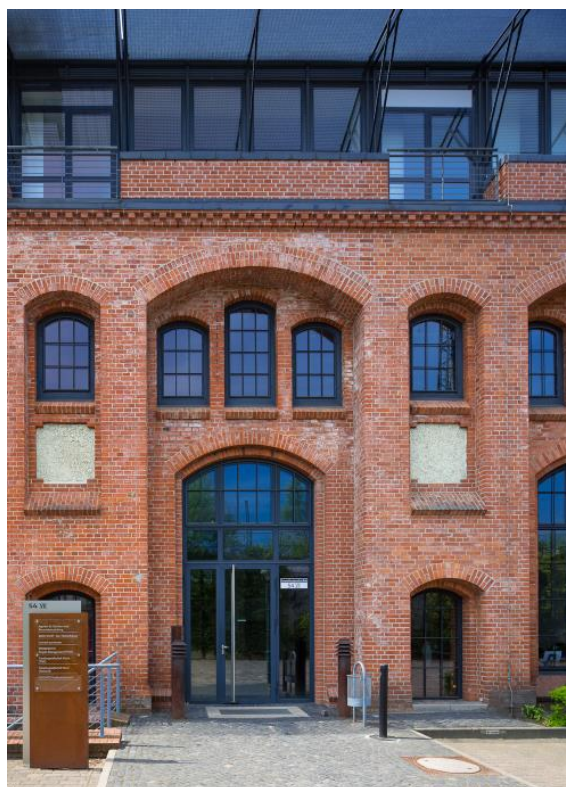
Haupteingang Kesselhaus Süd
